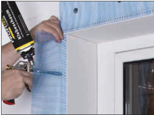
Passgenaue Montage in der Laibung
